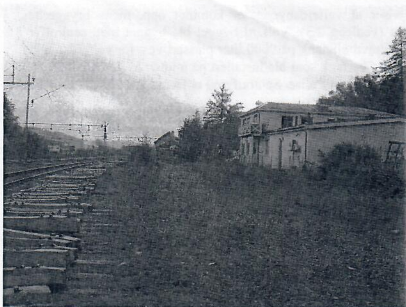
Figur 2.3. Den sørlige delen av stasjonsområdet. Svillene til et tidligere sidespor kan ses under betongsvillene i venstre del av bildet. Bildet er tatt fra sør.
